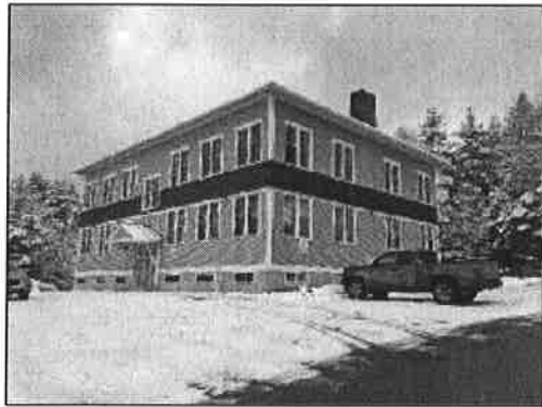
Exterior – SE corner
