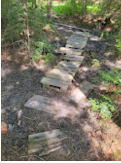
Boardwalk 2.jpg 5985K
